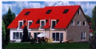
Stuttgart-Zazenhausen Kirchenäckerstraße 32/Nazariusweg
